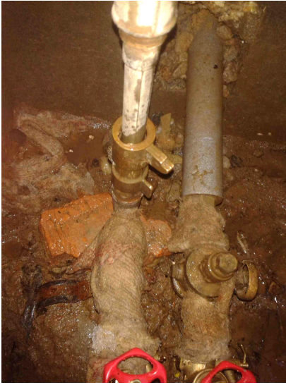
Dolní díl – uzávěr a vypouštěcí ventil
