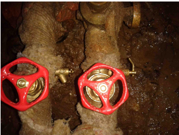
Dolní díl – uzávěr a vypouštěcí ventil
