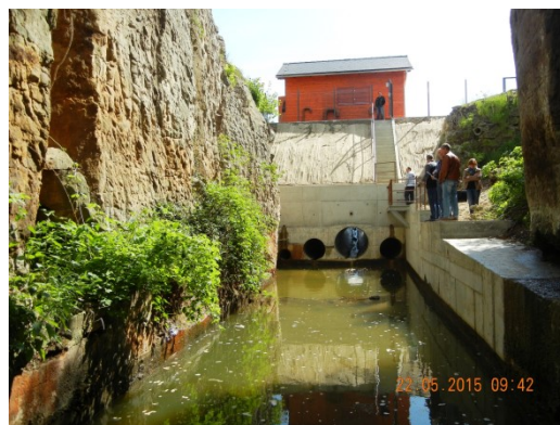
Výpušť rybníka zpod hráze
